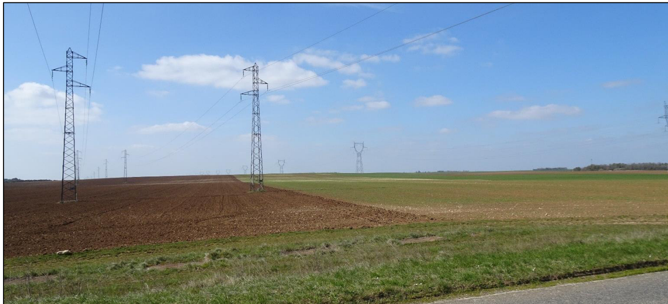
Figure 140 : Photographie des lignes haute tension qui traversent la moitié nord du territoire d'étude (Crédit photo : NCA Environnement)
