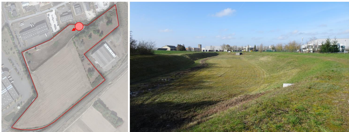
Figure 180 : Photographie du bassin de rétention du site d'étude capturée depuis son extrémité est (Crédit photo : NCA Environnement)
