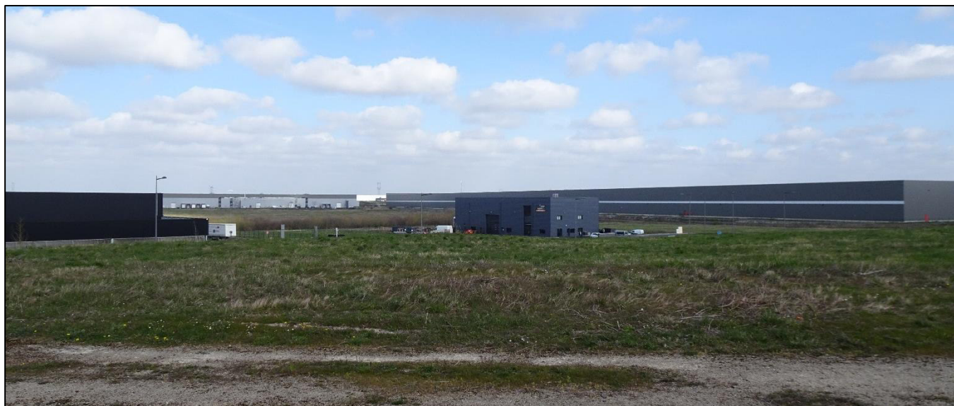
Figure 137 : Photographie de bâtiments industriels de Mer (Crédit photo : NCA Environnement)
