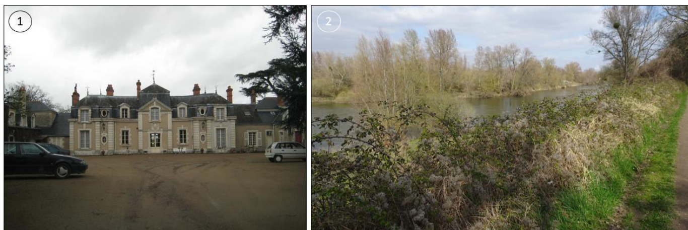
Figure 156 : Prise de vue 1 - Photographie du Château de Collier / Prise de vue 2 - Photographie du paysage visible depuis le chemin passant devant le Château
