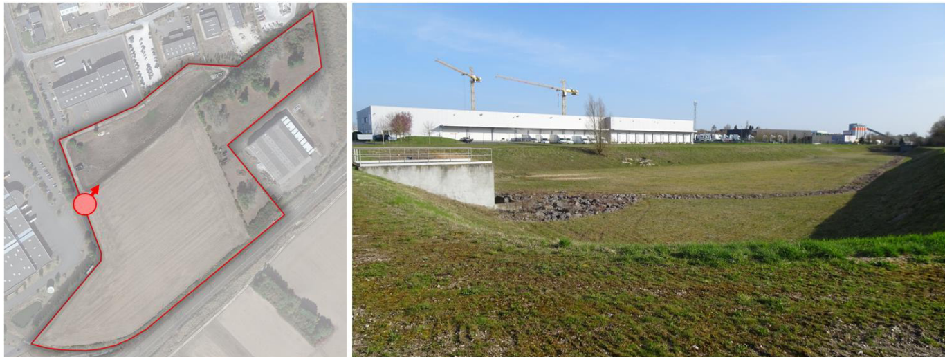
Figure 179 : Photographie du bassin de rétention capturée depuis son extrémité ouest (Crédit photo : NCA Environnement)
