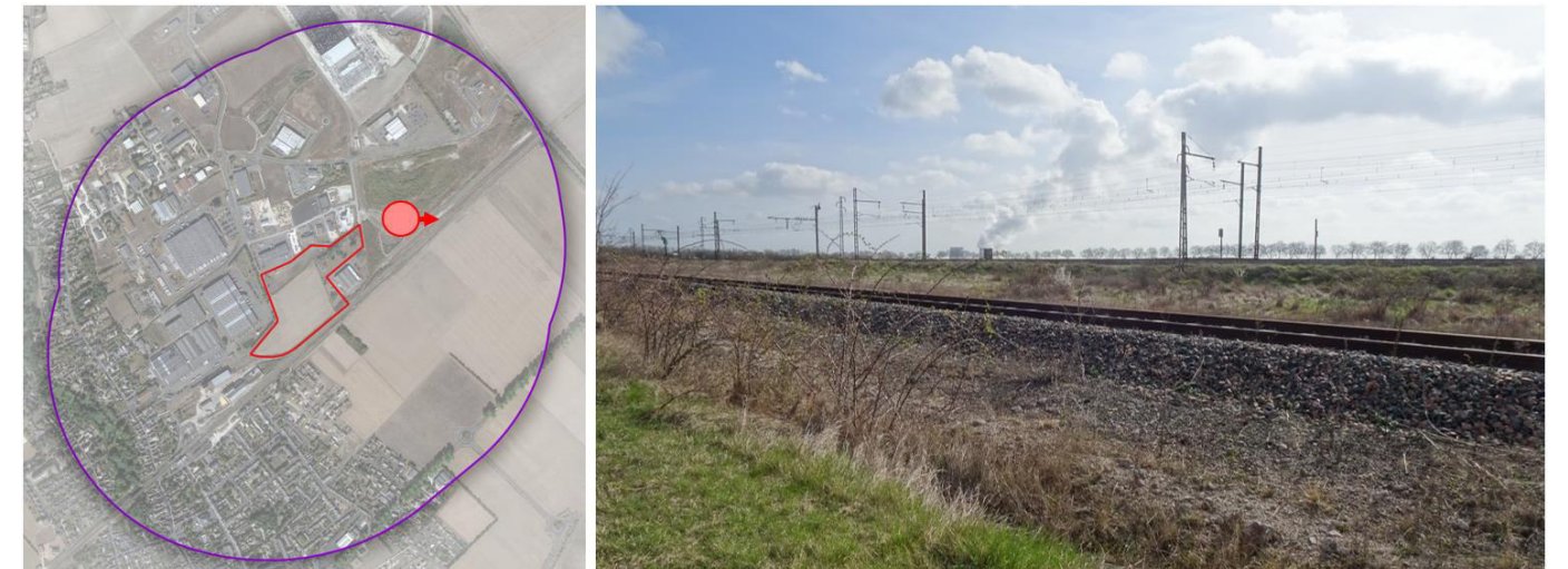
Figure 172 : Photographie de la voie ferrée qui traverse l'aire d'étude immédiate (Crédit photo : NCA Environnement)
